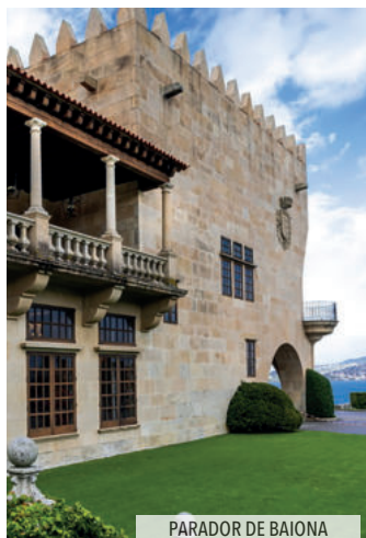
PARADOR DE BAIONA
